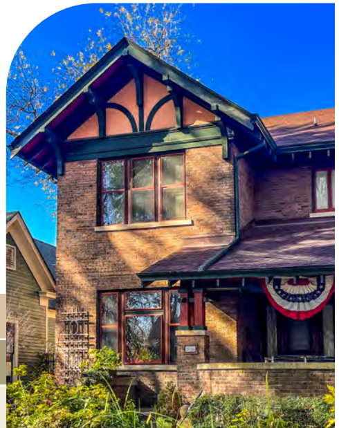
Baer House (1010 S. Rock St.)
