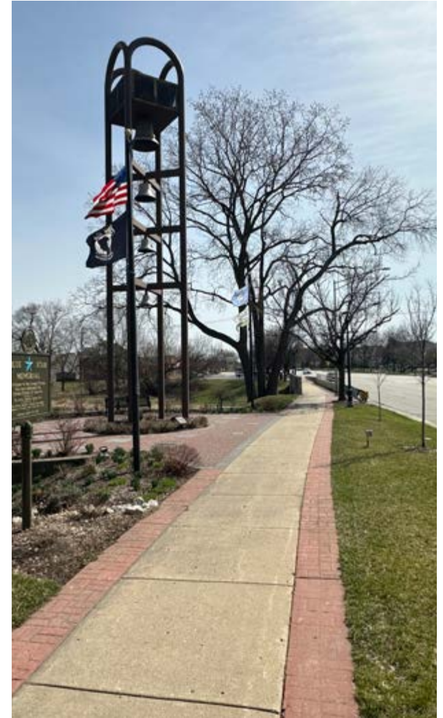
KIRCHOFF ROAD MULTIUSE PATH
